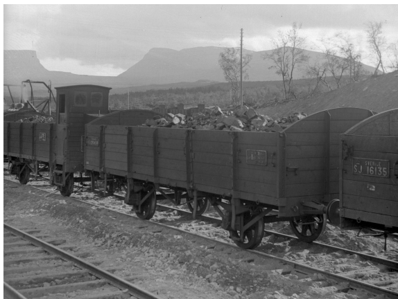
Uppifrån vänster: Leveransfoto från 1907 av SJ N3 22043 med handbroms. Leveransfoto från 1906 av SJ NN3 21391 utan broms. Leveransfoto från 1903 av SJ R3 19263 utan broms. SJ I3 121459 och 13135 med flera I3-vagnar på Abisko station runt 1909-1915. Den borte med broms, den i mitten obromsad. JvmKAGB00043, JvmKAGB00042, JvmKAGB00039 och JvmKAAA00268
