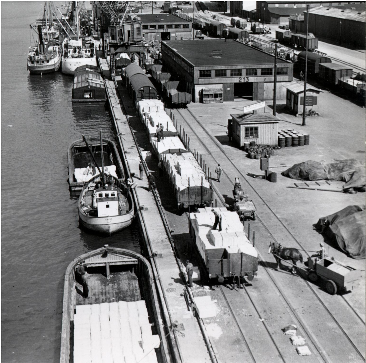
Göteborgs hamn. Närmast en Os-vagn med avkapad bromshytt. Detta är en variant på ombyggnad som vissa vagnar med bromshytt fick. Vagnen har även tryckluftsbroms vilket syns på de dubbla vita strecken. Efter den en standard O, följt av tre Os. På spåret bredvid står fler Os-vagnar framför magasin 213. Foto av Walter Pöppel runt 1935. JvmKDAA10184
