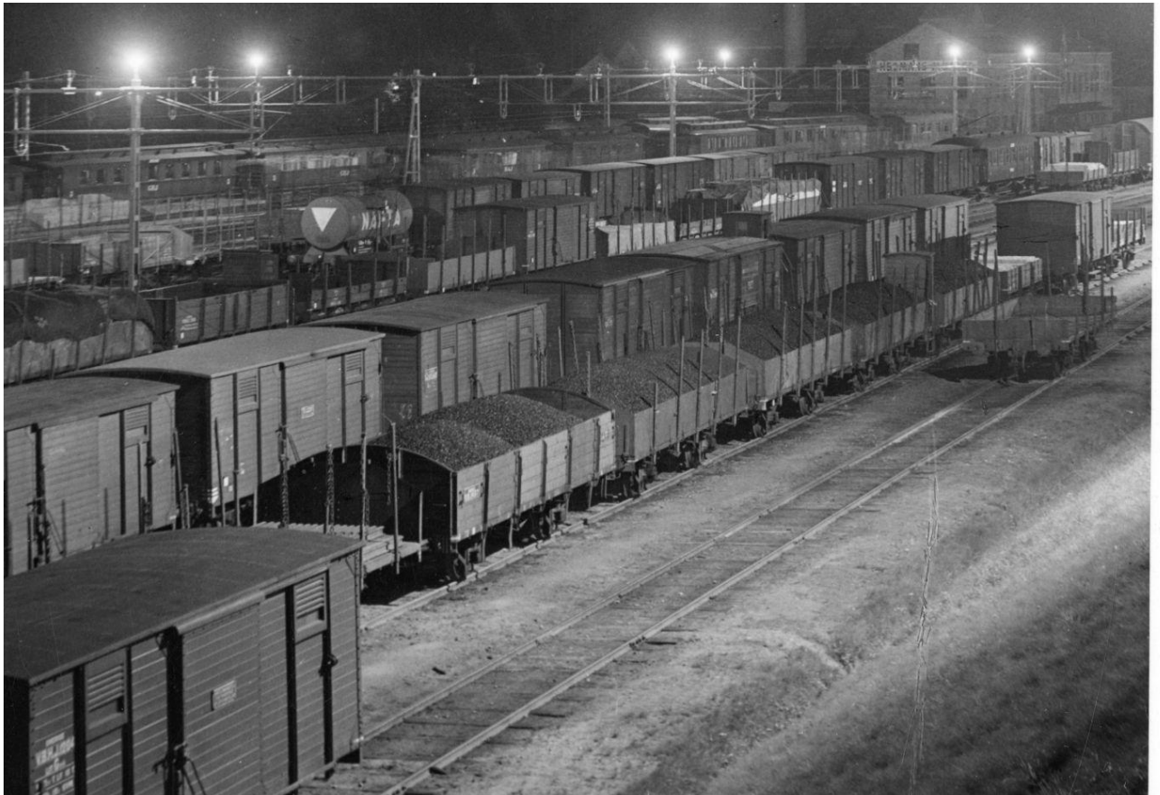
En littera Is och fyra littera Os på rad, lastade med grus eller liknande på bangården i Borås. Is-vagnen är antagligen ägd av GBJ (Göteborg-Borås Järnväg) har därför inte blivit ombyggd till Os. De fyra SJ-ägda Os-vagnarna har samtliga tryckluftsledning, men ingen tryckluftsbroms, vilket syns på de enkla vita hörnmarkeringarna. Tredje vagnen har kvar sin bromshytt och har alltså handbroms. Fotot taget 1936. JvmKDAA00984
