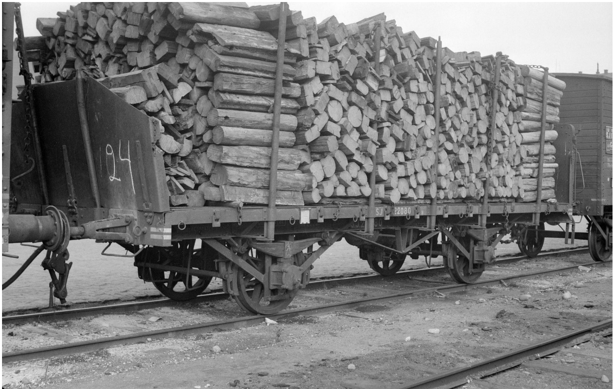
SJ Os 22080 lastad med ved, fotograferad någon gång runt 40-talet. Sidolämmarna har här fällts in och kan skymtas under lasten. Vagnen har tryckluftsbroms system Kunze-Knorr, samt plattform för rangerbroms som skymtas bakom veden. JvmKBDB01691
