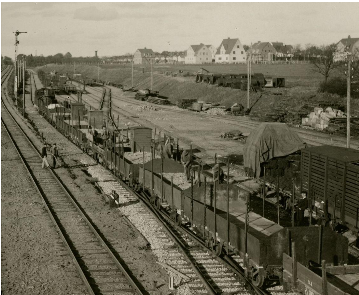
Flera Os-vagnar i grusningståg utanför Lund 1926. De närmaste två vagnarna är obromsade med standardmodellen på lämmar, där gavlarna är upphöjda i mitten. Den tredje vagnen i raden har den äldre varianten med lägre lämmar som inte går upp vid gavlarna, samt har handbromskuren kvar, men är försedd med tryckluftsledning (men ej tryckluftsbröms). Längre bort skymtar två till Os med de lägre lämmarna och bromskur. JvmKDAA05655
