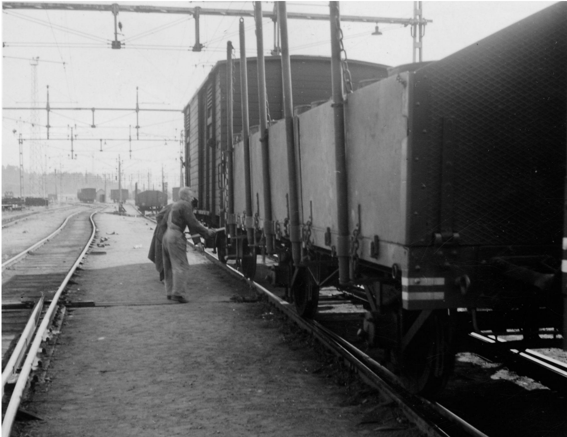
Vagnavsyning och förberedelser inför avgång på Hallsbergs rangerbangård efter avslutad rangering. Littera Os med tryckluftsbröms. Foto A. Blomqvist, juli 1941. JvmKDAF05076
