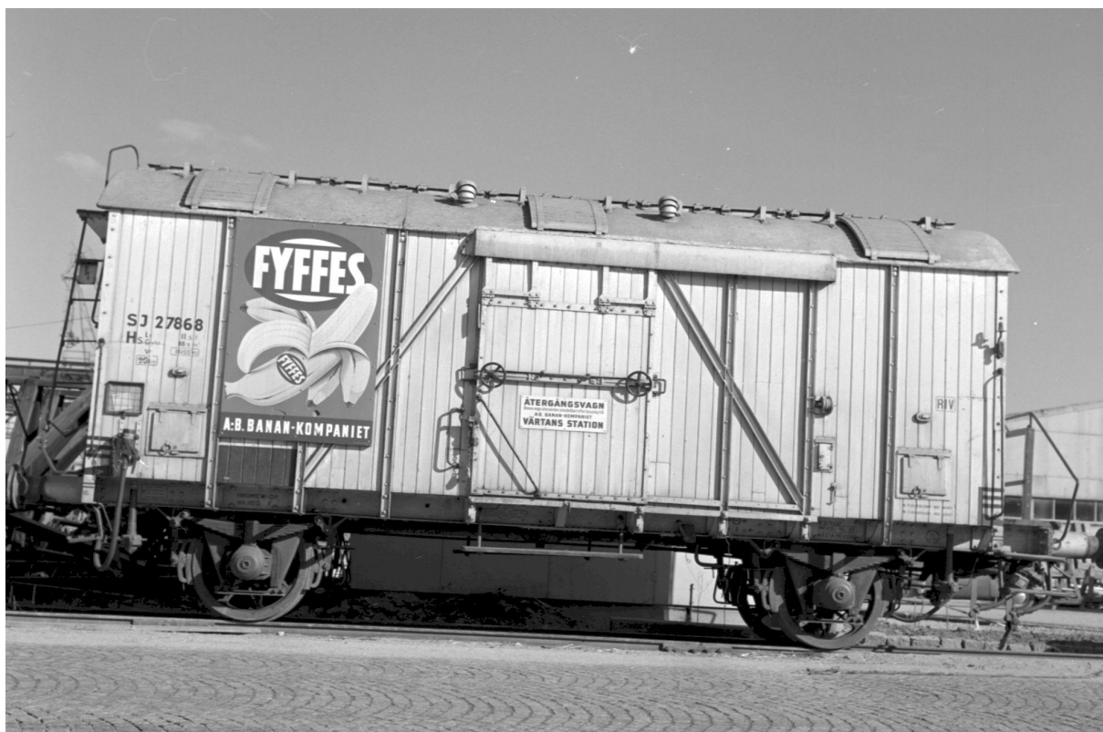
SJ Hs 27868 anpassad för banantransporter för A.B. Banan-kompaniet från Stockholms frihamn i Värtan, Stockholm. Vagnen har försetts med snedsträvor för att förstärka korgen, men har kvar skjutdörrarna. Foto i mars 1959 av John Hylterskog. JvmKBDB09184
