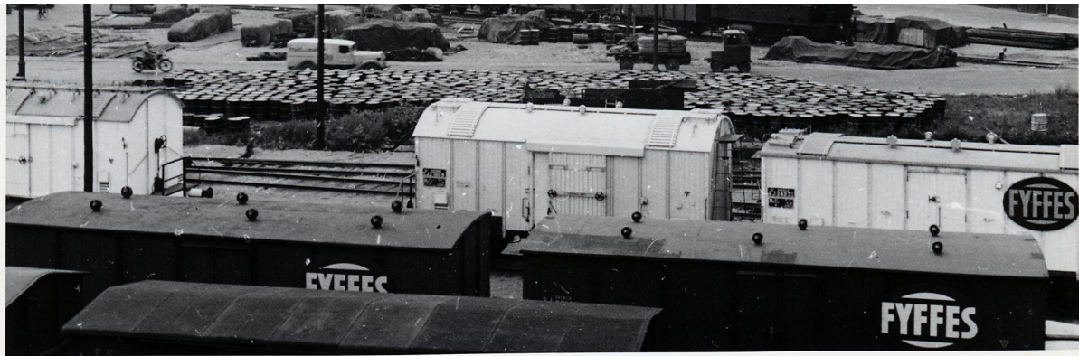
Tre vitmålade kylvagnar littera Hs i Göteborgs frihamn. Från vänster syns hälften av en Hs med högvälvt tak som har byggts om med isbehållare längs hela taket, i mitten en Hs med högvälvt tak som har isbehållare vid gavlarna, till höger en Hs modell 1907 med lågt tak och isbehållare i gavlarna anpassad för banantransporter. Foto från 1940-talet. JvmKDBA02682
