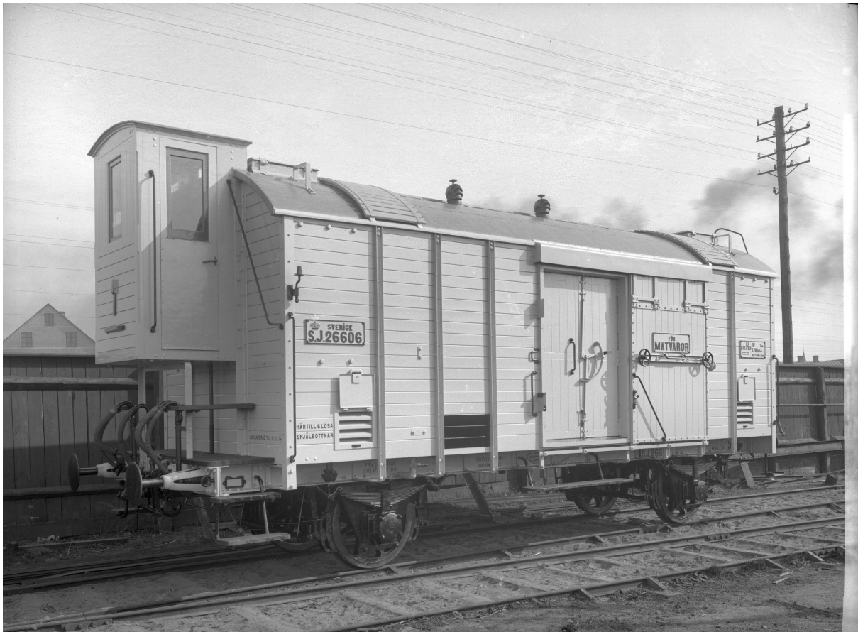
Leveransfoto på SJ Hs 26606 i april 1913. Vagnen har ställts upp så att man ser de dubbla lagren med dörrar, samt ventilationsluckorna för att ventilera ut vagnen när den inte är kyld. Denna vagn har iskorgar i båda gavlarna vilket man kan se på takluckorna i vardera ände av vagnstaket. JvmKAGB00018
